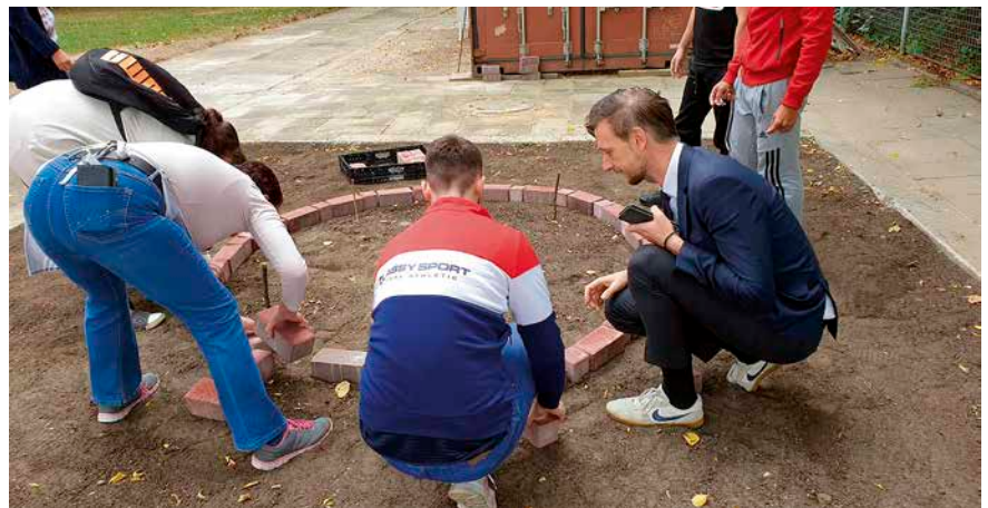
Bau der Feuerstelle
